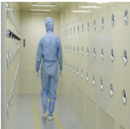
ورودی یک اتاق تمیز
