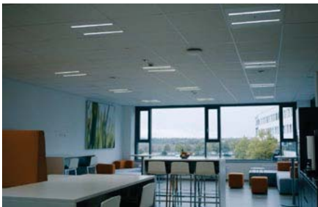
تنظیم نور خروجی براساس نور محیط (کم نور بودن چراغ‌های نزدیک به پنجره)
