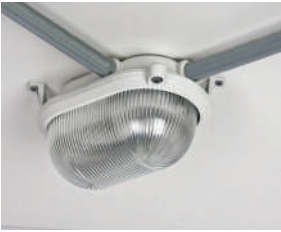
قابلیت ورود و خروج لوله کاندویت و یا کابل از سه طرف چراغ به منظور لوپینگ
