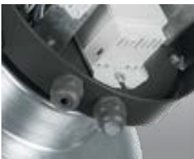
استفاده از دو گلند برای لوپینگ
